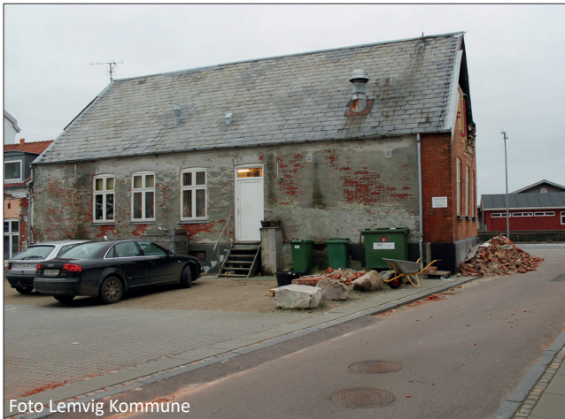
HAVNEGADE 26 - FØR RENOVERING (2015)
