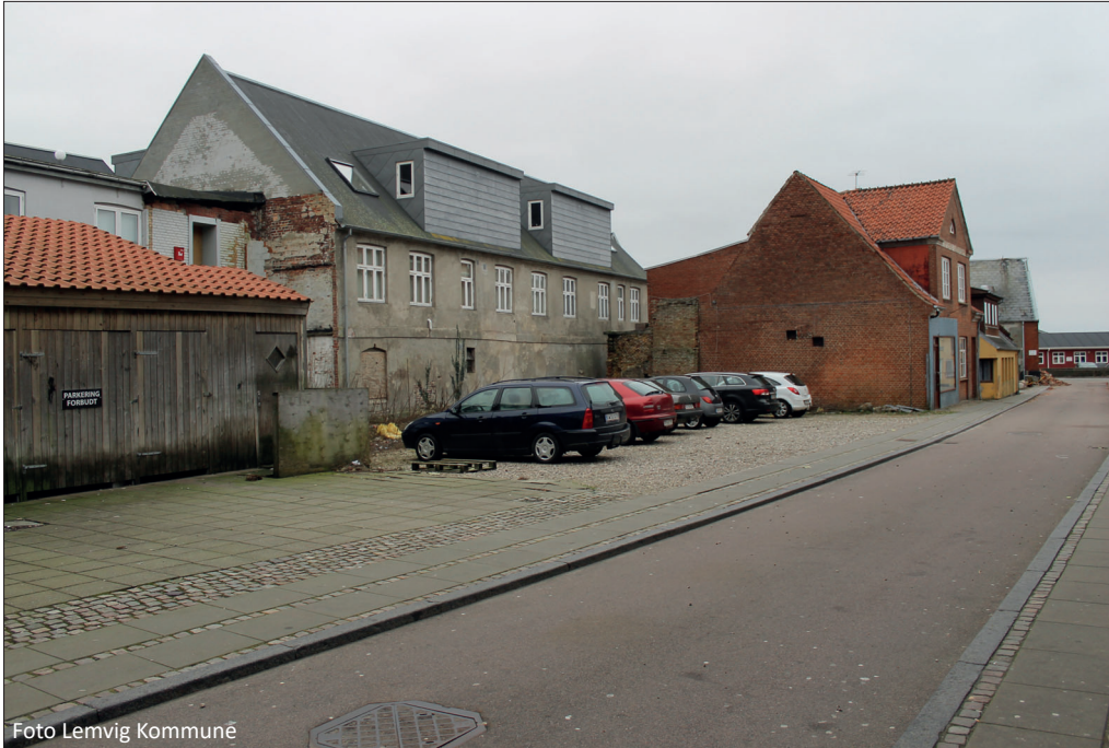
WEIBELSGADE - FØR NEDRIVNING OG RENOVERING (CA. 2015)
