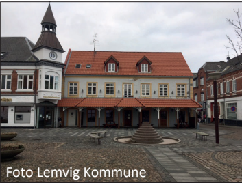
TORVET 2 - FØR RENOVERING (CA. 2018)
