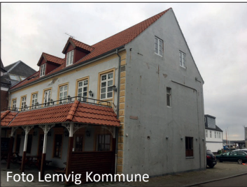
TORVET 2 - FØR RENOVERING (CA. 2018)
