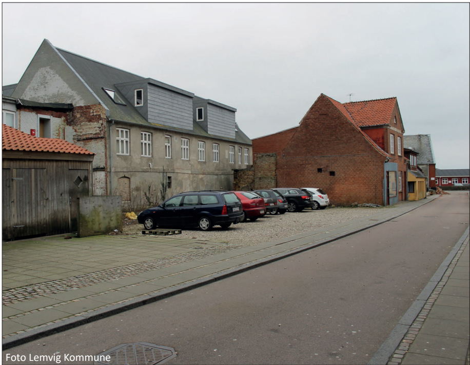
WEIBELSGADE - FØR NEDRIVNING OG RENOVERING (CA. 2015)
