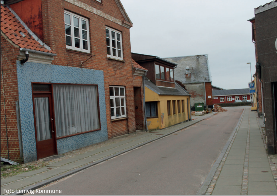
WEIBELSGADE 5 OG 7A- FØR NEDRIVNING OG RENOVERING (2014)
