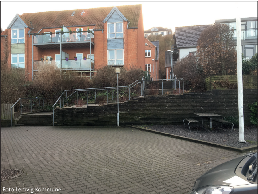
TRAPPE TIL FREDERIKSGADE MED FORPLADS - FØR OMDANNELSEN (2018)
