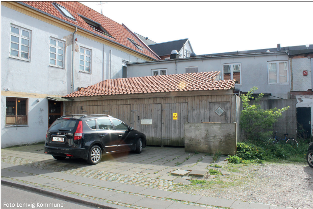
TORVET 2 - FØR NEDRIVNING OG RENOVERING (CA. 2018)
