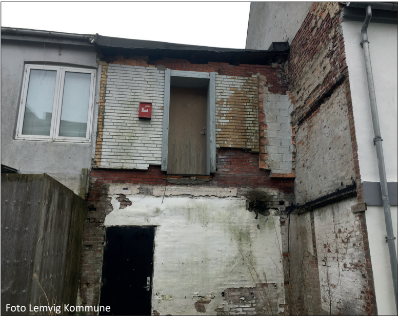
TORVET 2 - FØR NEDRIVNING OG RENOVERING (CA. 2018)
