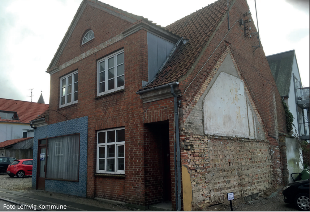
WEIBELSGADE 5 - FØR NEDRIVNING (2016)
